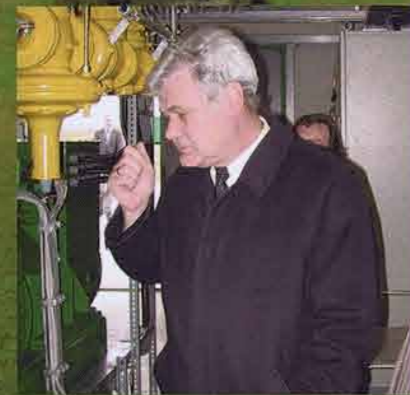
Umweltminister Herr Methling besichtigt das Blockheizkraftwerk anlässlich der Fördermittel-Übergabe
